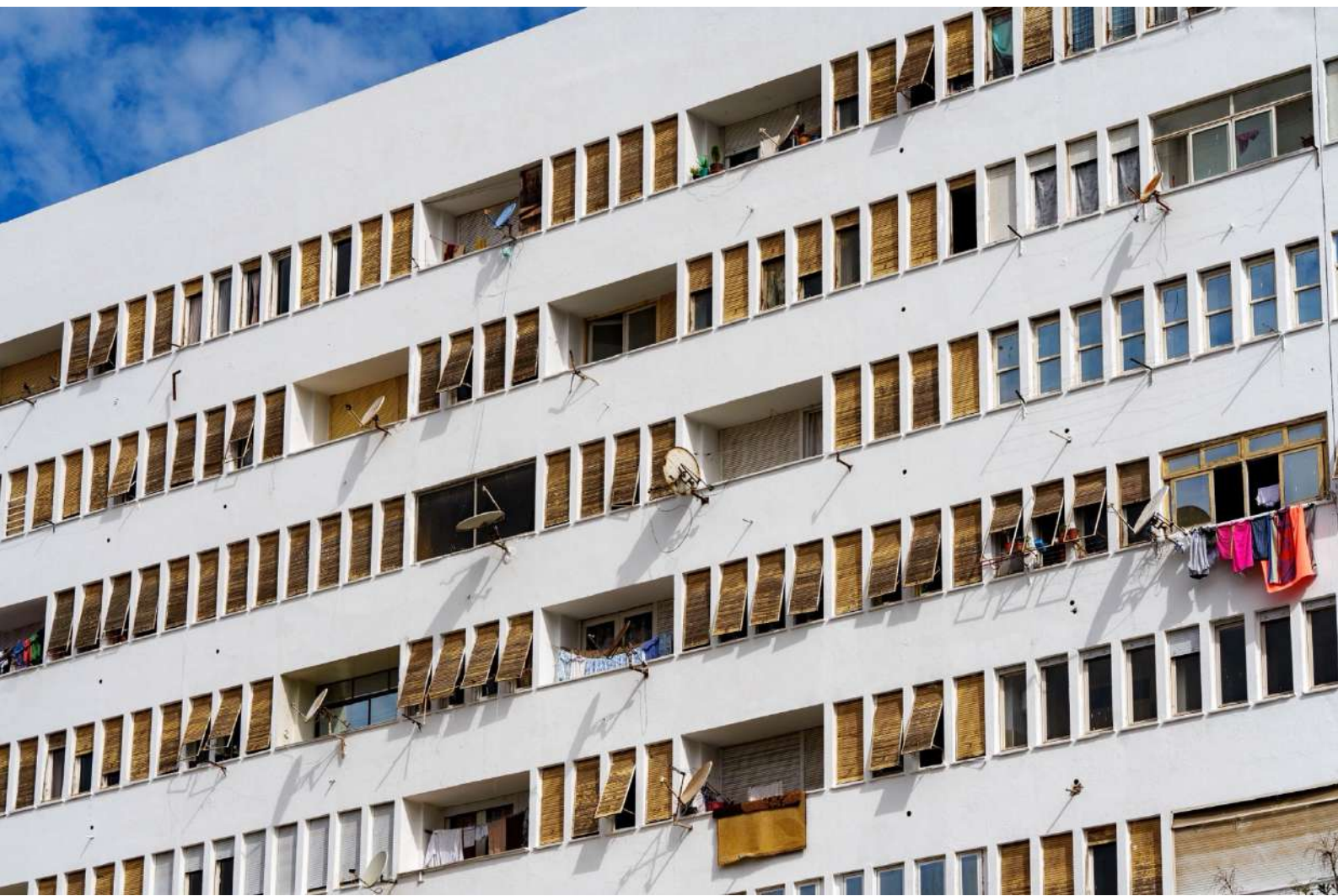
Protection solaire- 2023 Début 1950 - Alexandre Courtois
